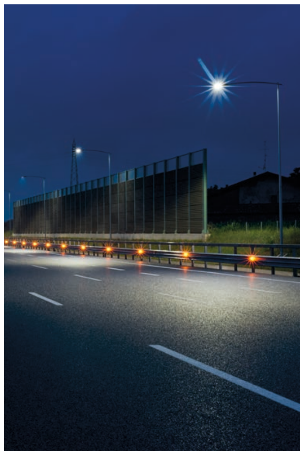
AUTOSTRADA PEDEMONTANA LOMBARDA S.P.A. Autostrada Pedemontana Lombarda
