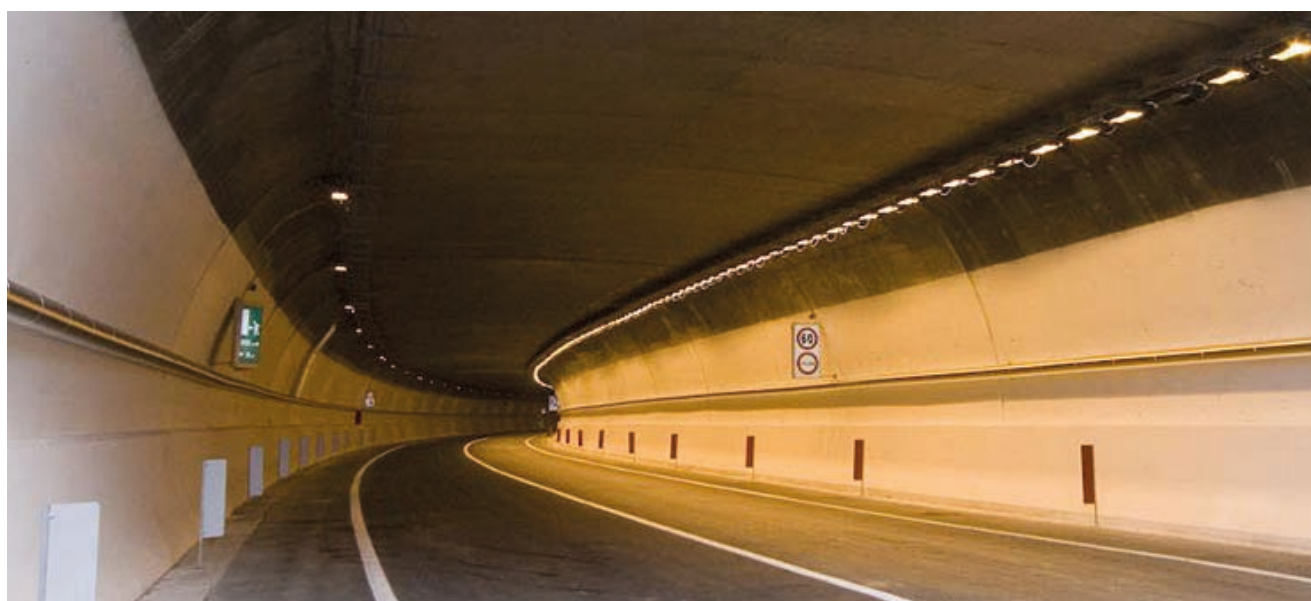
AUTOSTRADA DEI FIORI S.P.A. - Illuminazione Gallerie AdF
