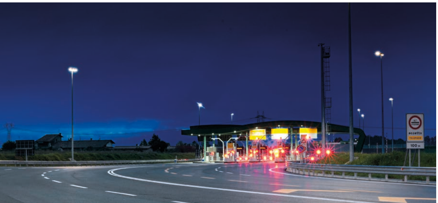
AUTOSTRADA PEDEMONTANA LOMBARDA S.P.A - Autostrada Pedemontana Lombarda
